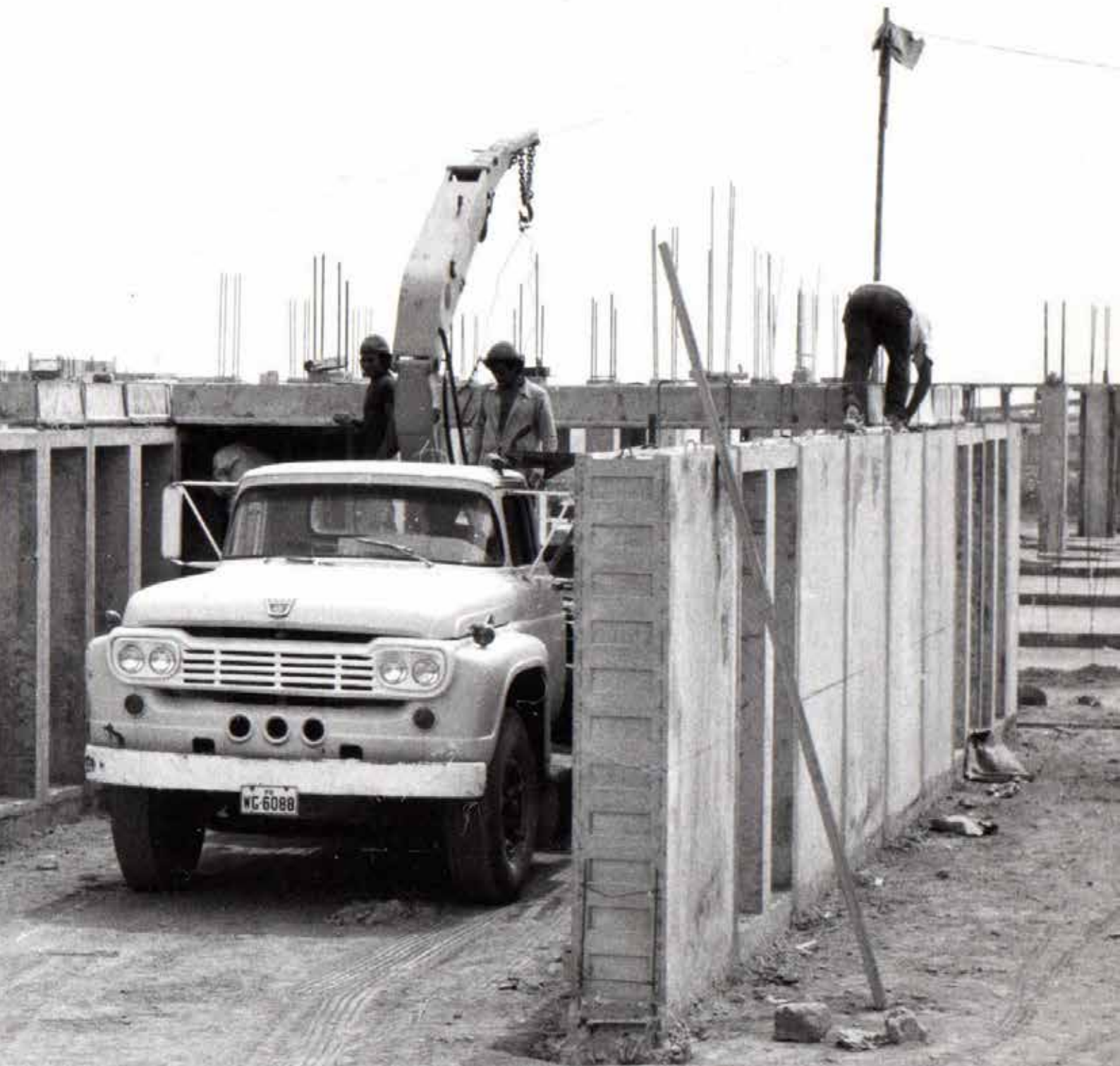
BUDOWA DOMÓW Z PREFABRYKATÓW Dzięki uprzejmości Petera Landa
